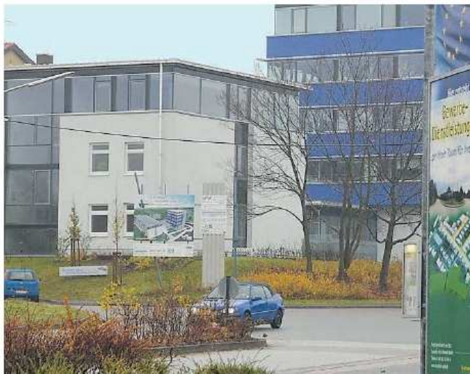
Im zweiten Gebäude des Gründerzentrums im Saarpfalz-Park hat die Firma ILC Prostep ihren Sitz.
